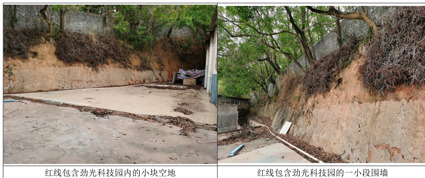
图 2.1-1 地块内部现状勘察实景图
